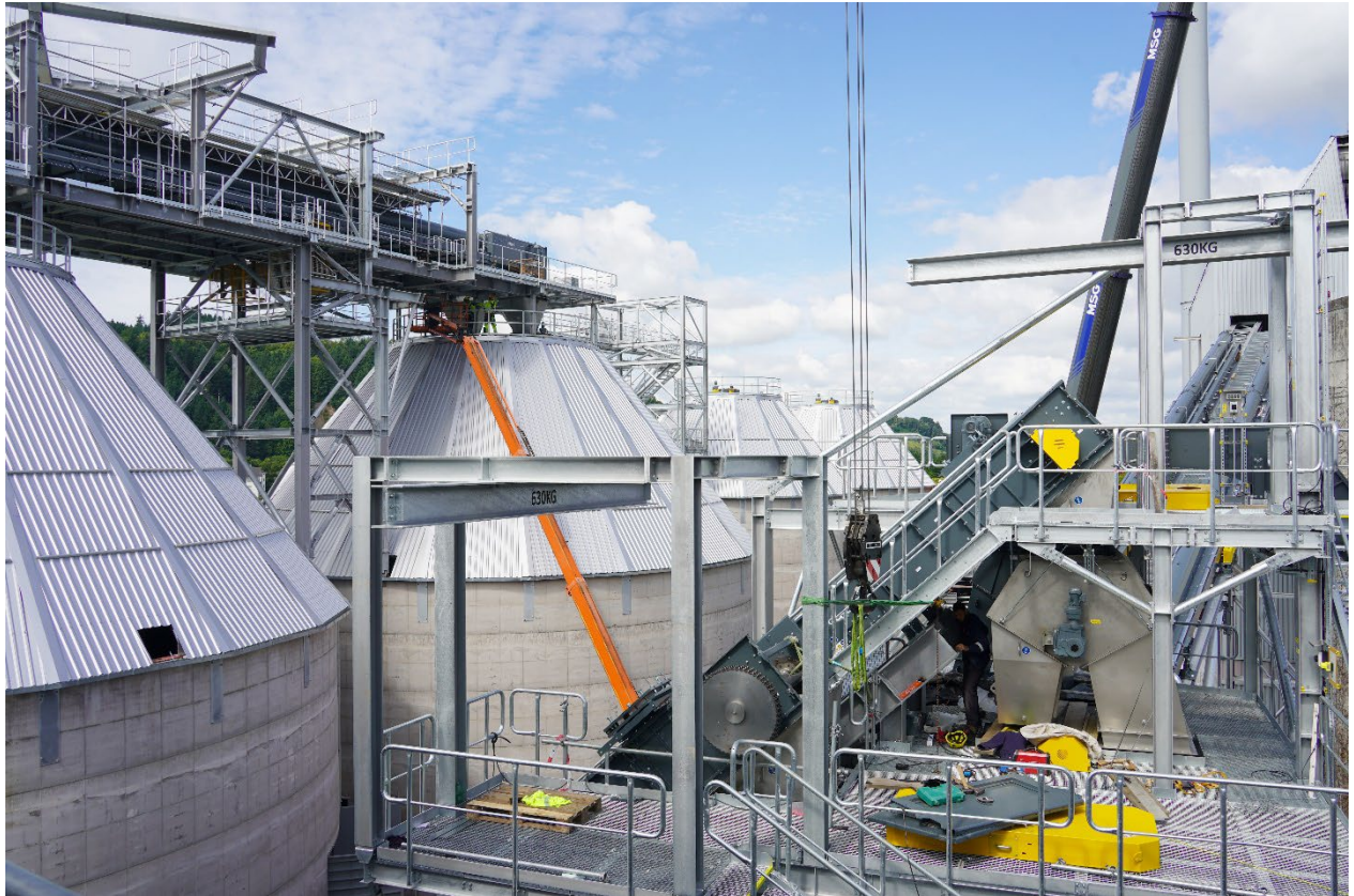
Abbildung 2: Die Umbaumaßnahmen am Heizkraftwerk schreiten weiter voran. Quelle: Koehler-Gruppe
