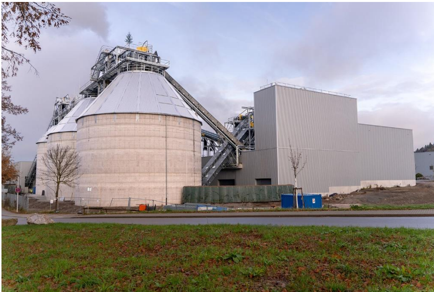
Abbildung: Befinden sich auf der Zielgeraden – die Umbauarbeiten am Heizkraftwerk der Koehler-Gruppe in Oberkirch.
