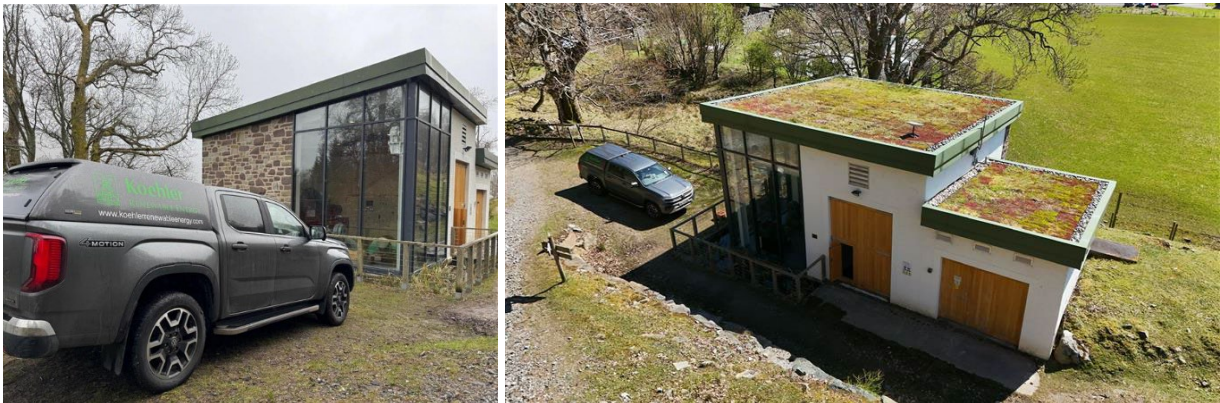
Foto: Planta hidroeléctrica de Allt Mor en Kinloch Rannoch, Perthshire. Fuente: Koehler Renewable Energy
